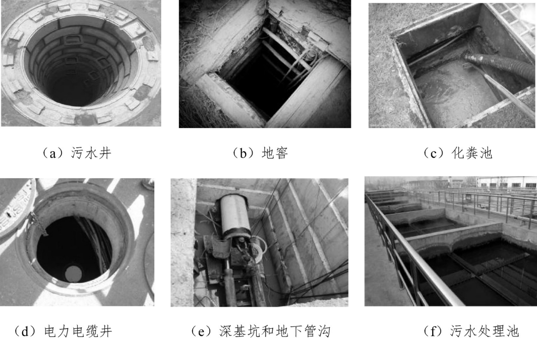
图 1-4 地下有限空间
